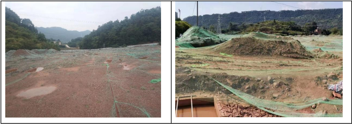
图 3.2-1 本项目弃方点土方堆置现状
