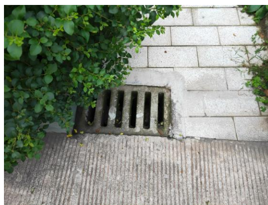
医院内既有雨水排水系统（雨水井、雨水口）
